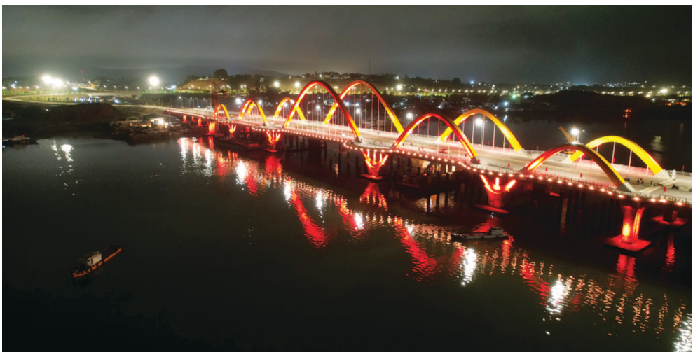
Cầu Tinh Yêu - cầu 6 làn xe đầu tiên của tỉnh Quảng Ninh, cũng là công trình đầu tiên nổi Hạ Long - Hoành Bồ sau sáp nhập. Ảnh: TTTT tỉnh
